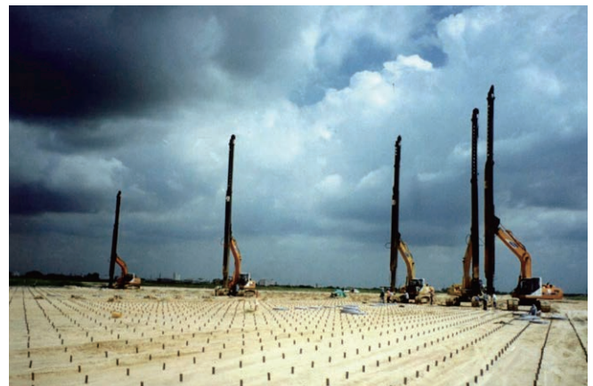
施作35m垂直排水帶，總計施作40,000,000m
