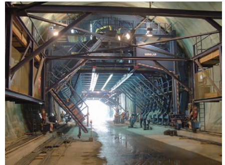
高鐵隧道穿越國道3號-覆土深度9m
