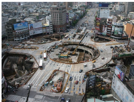
臺灣最大圓形開挖(直徑140m)-高雄捷運
