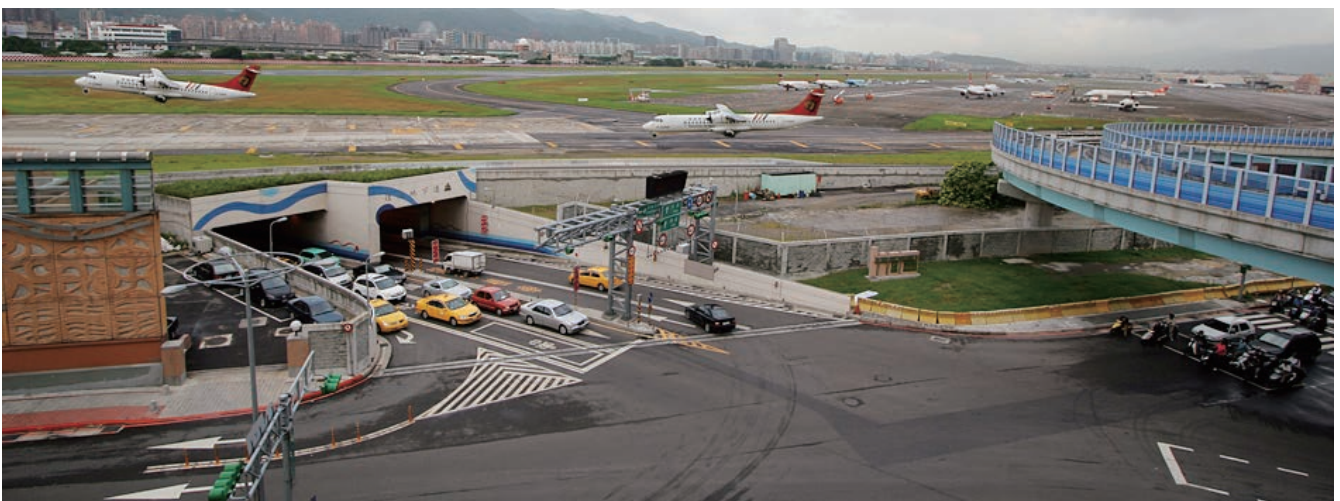
軟弱地層中結合管幕與無限自走箱涵推進工法，達到沉陷管控目標
